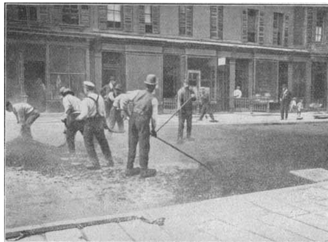
Fig. 11. Abgleichen der Makadamschicht.
