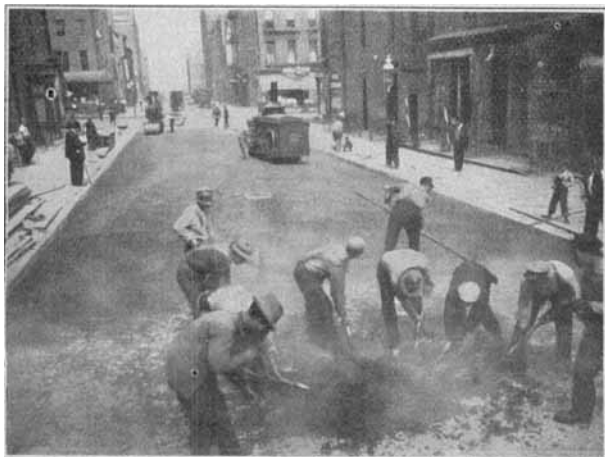
Fig. 10. Ausbreiten des Asphaltmakadams.
