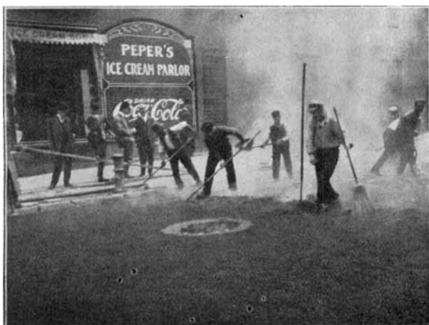
Fig. 13. Aufbringen der Sandasphaltschicht.
