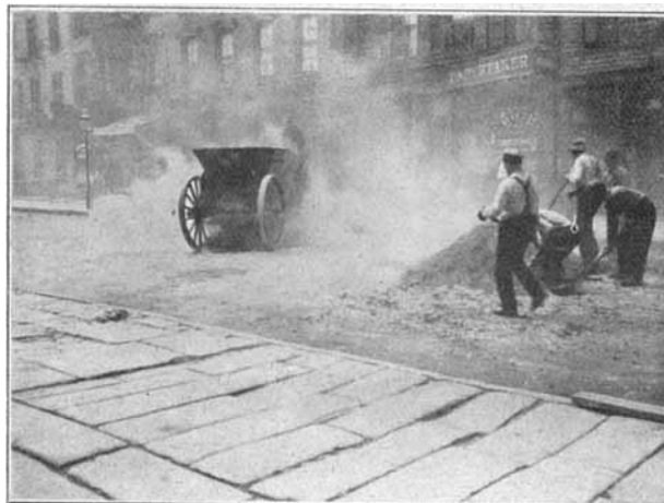
Fig. 9. Anfahren des Asphaltmakadams.
