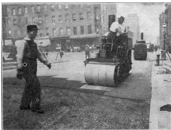
Fig. 14. Abwalzen der Sandasphaltschicht.
